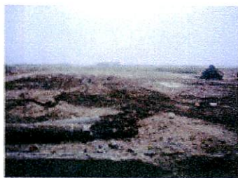
折れた電柱、家々の土台だけが残って……
